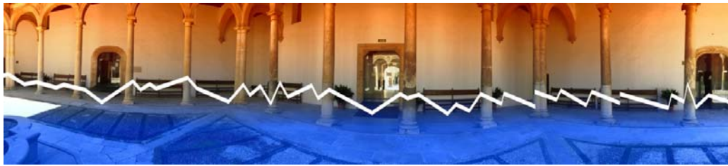
Figura 2. Metáfora gráfica, panorámica, que puede ilustrar el estado de conservación del Patio de la Capilla del Hospital Real
