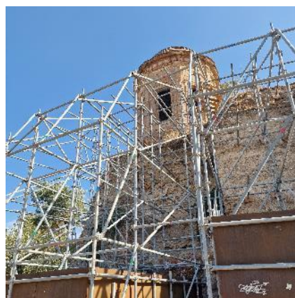
Vista del templete que será objeto de intervención en la Fase 2 y apuntalamiento de seguridad bajo el mismo para garantizar su estabilidad hasta que se lleve a cabo el refuerzo de la torre sobre la que se asienta.
