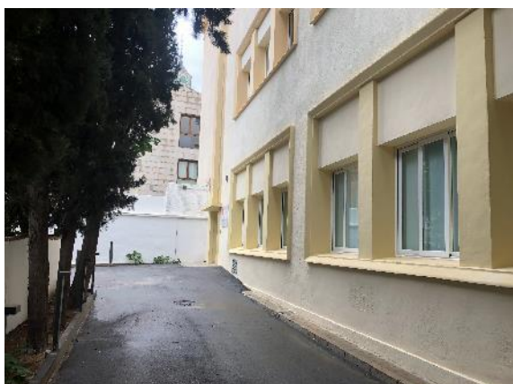
Mejora de acceso e instalación de señalética
