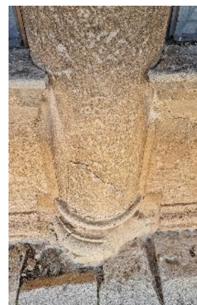
Desmontaje de la cubierta y estado de deterioro de los pilares de piedra que soportaban los arcos de las ventanas
