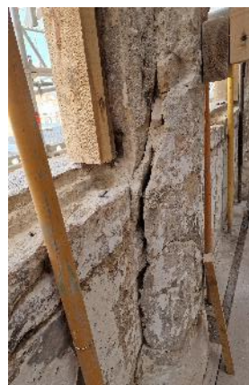
Desmontaje de la cubierta y estado de deterioro de los pilares de piedra que soportaban los arcos de las ventanas
