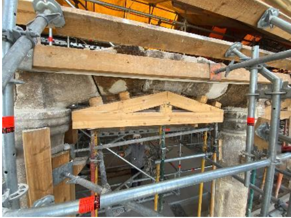
Proceso de montaje de las piezas restauradas que conforman los pilares y arcos en su posición originaria.
