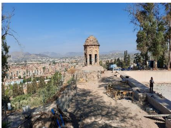
Vista del templete que será objeto de intervención en la Fase 2 y apuntalamiento de seguridad bajo el mismo para garantizar su estabilidad hasta que se lleve a cabo el refuerzo de la torre sobre la que se asienta.
