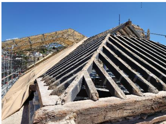
Desmontaje de la cubierta y estado de deterioro de los pilares de piedra que soportaban los arcos de las ventanas
