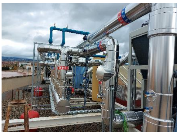
Distribución de colectores y disposición de equipos de bombeo en la cubierta del edificio.
