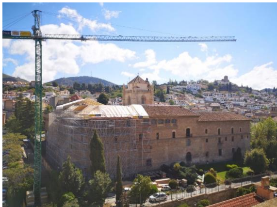
Andamiaje exterior para estabilización de la fachada.
