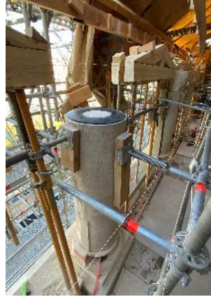
Proceso de montaje de las piezas restauradas que conforman los pilares y arcos en su posición originaria.
