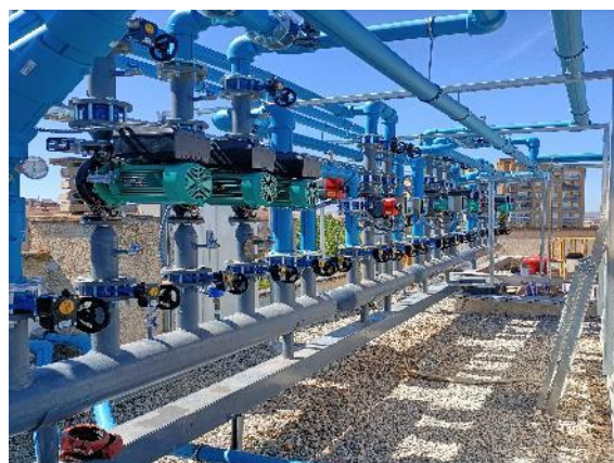
Distribución de colectores y disposición de equipos de bombeo en la cubierta del edificio.
