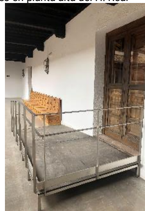
Demolición de muro medianero en mal estado junto al aparcamiento y dotación de rampas accesibles en planta alta del H. Real
