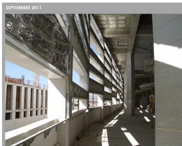
Estado actual del edificio de la Facultad de Ciencias de la Salud.
