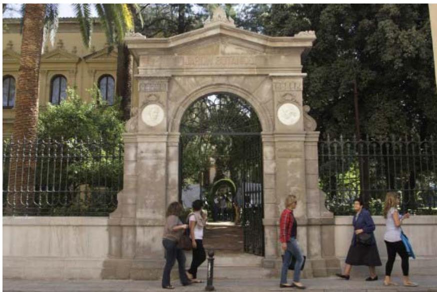
Estado de las Verjas del Jardín Botánico una vez finalizada la restauración.
