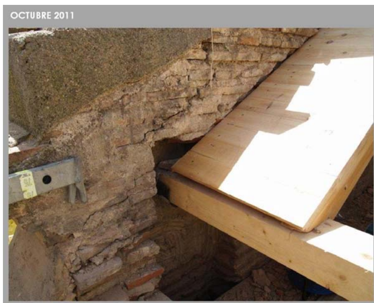
Estado de la restauración de la cubierta.
