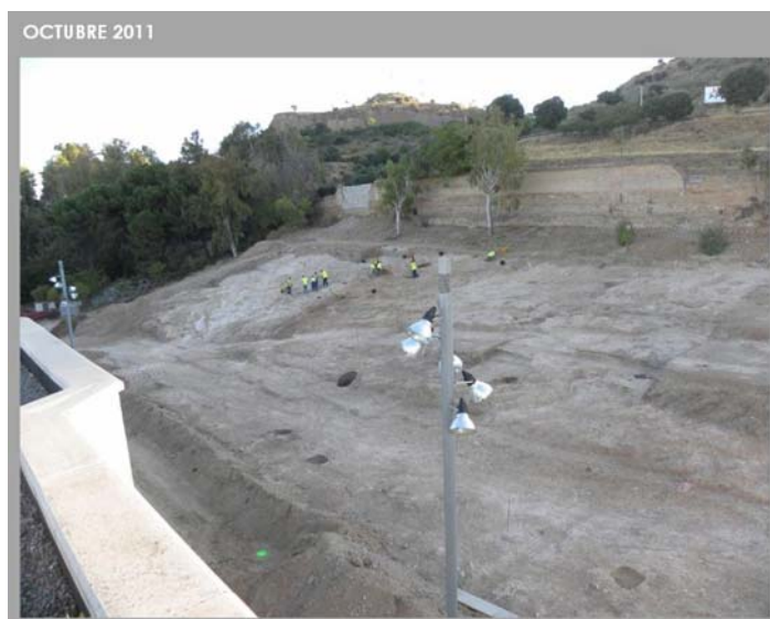
Estado de la intervención arqueológica en la zona que ocupará el edificio nuevo.
