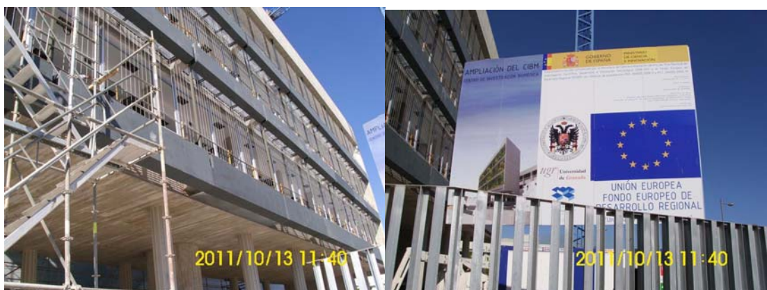
Fachada del edificio de ampliación del CIBM y cartel de obra.
