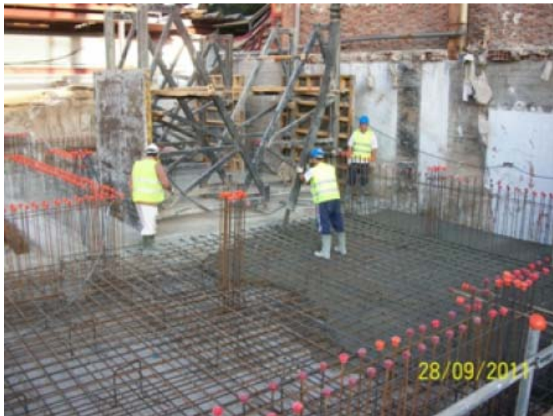
Situación de la intervención en el mes de septiembre.
