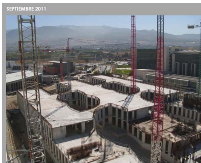
Estado actual de la Facultad de Medicina.
