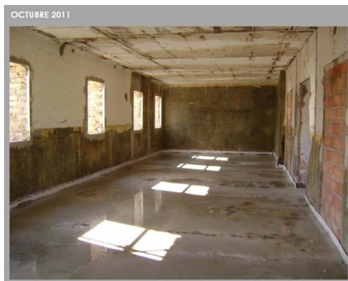
Situación de la obra una vez finalizada la demolición interior.
