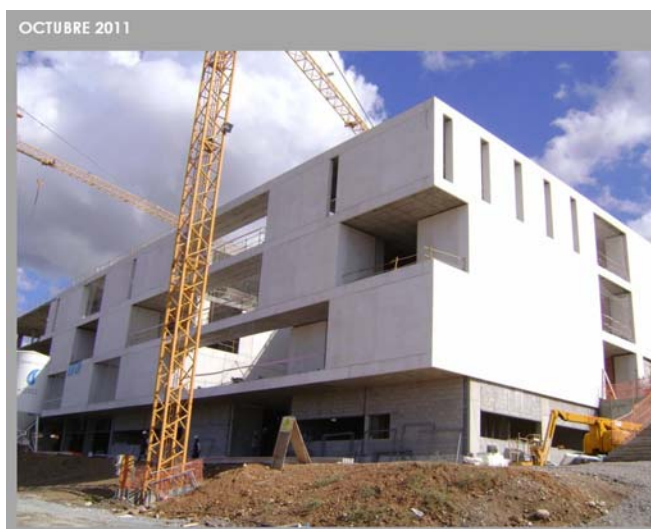
Estado actual de las obras.
