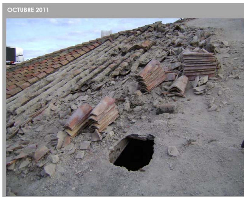
Estado de la intervención.
