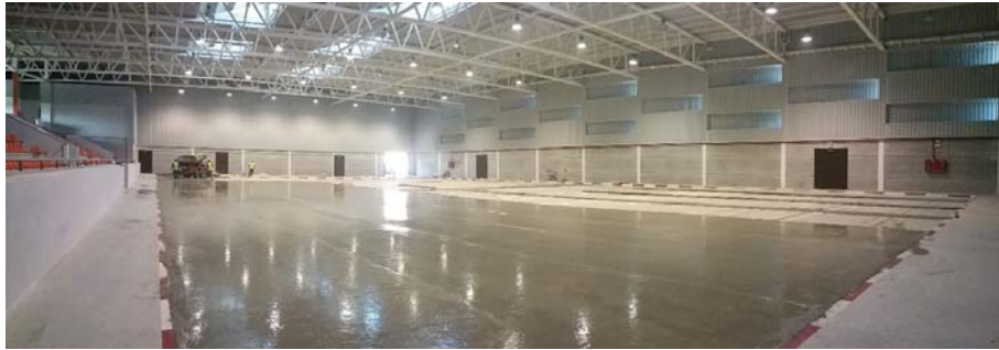
Vista panorámica del desarrollo de los trabajos para crear nuevos vestuarios y dotar de pavimento deportivo a la zona de pista
