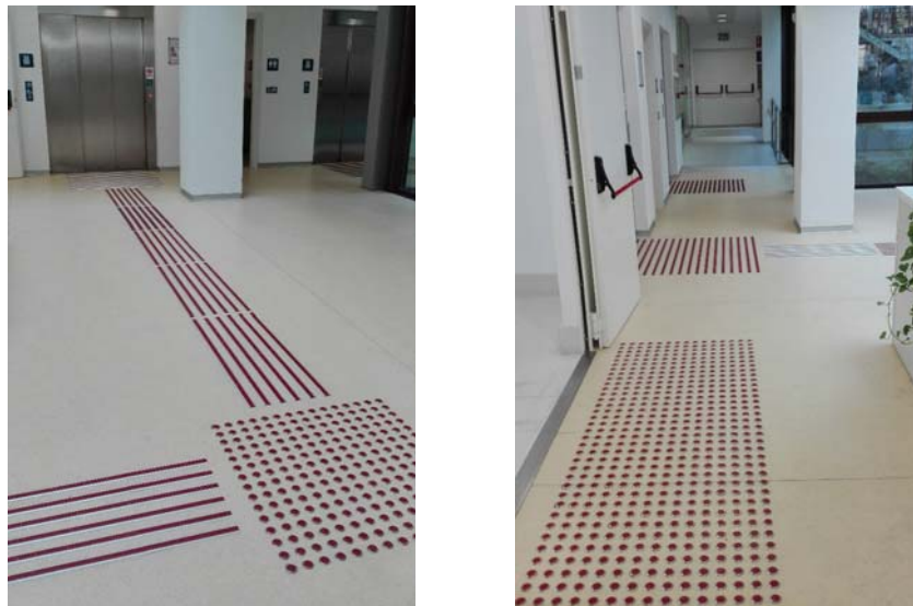
Vista de los pavimentos podotáctiles instalados para personas con disfunción visual
