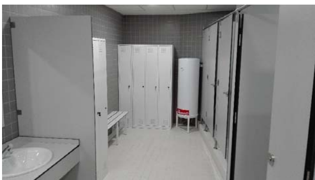
Vista de la zona de cabinas del vestuario
