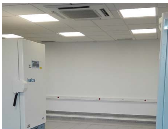
Vista interior del espacio acondicionado para su uso como sala fría
