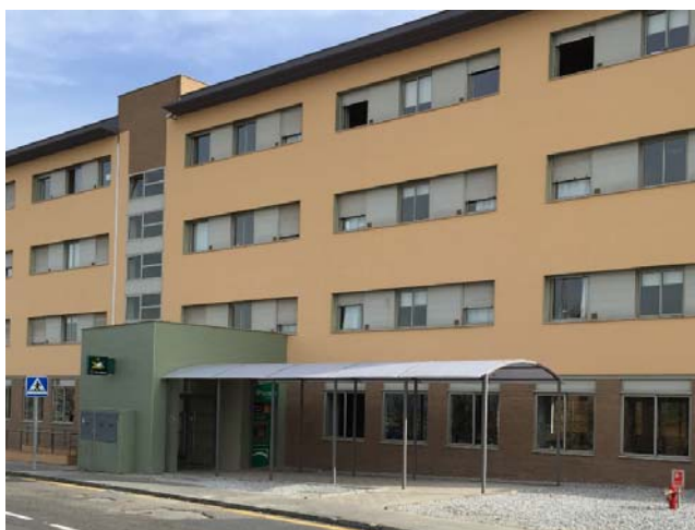
Vista de la pérgola instalada para proteger a los usuarios en el acceso al comedor
