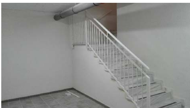
Vista de la nueva escalera para acceso seguro del personal de mantenimiento al cuarto de instalaciones
