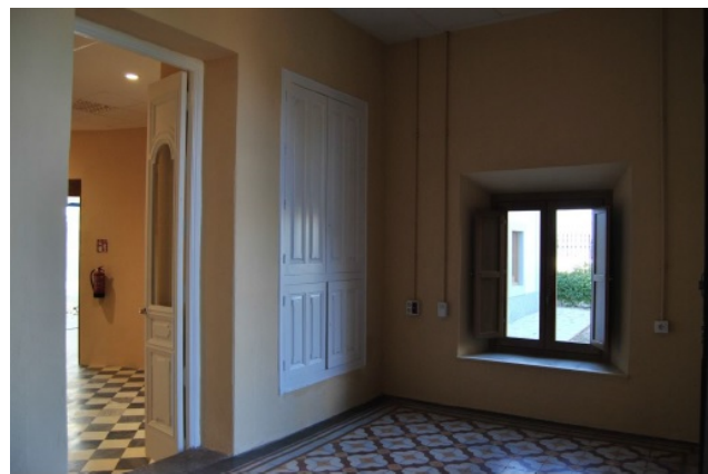
Vista interior de las solerías originales (sala meteorología) que han sido restauradas y recuperadas tras la intervención
