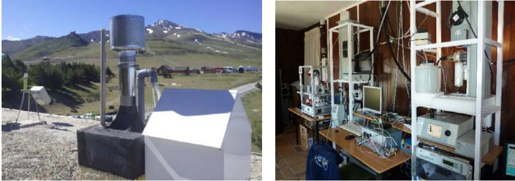
Vista de los equipos e instrumental de medida tanto en la cubierta del edificio como en la zona interior (biblioteca)
