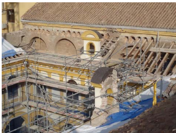
Vista de la cubierta desmontada sobre uno de los claustros perimetrales
