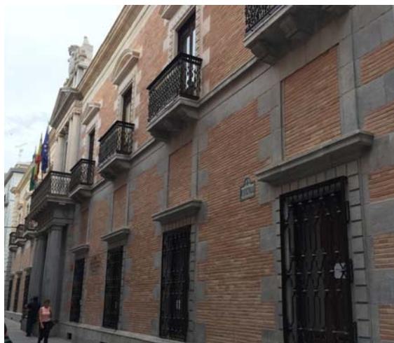
Vista de la fachada principal restaurada (Calle Puentezuelas)
