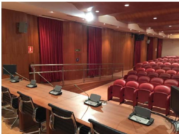
Vista de la nueva rampa de acceso al estrado para personas con movilidad reducida
