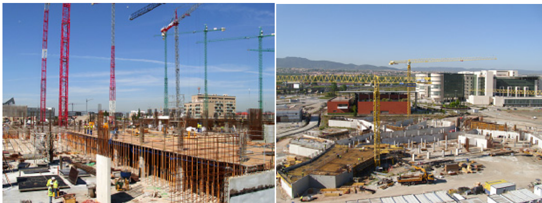
Fotografía 2: Obras del Campus Universitario de Ciencias de la Salud
