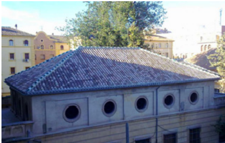
Fotografía 5: Obras de reparación de las cubiertas del C.M. Isabel la Católica
