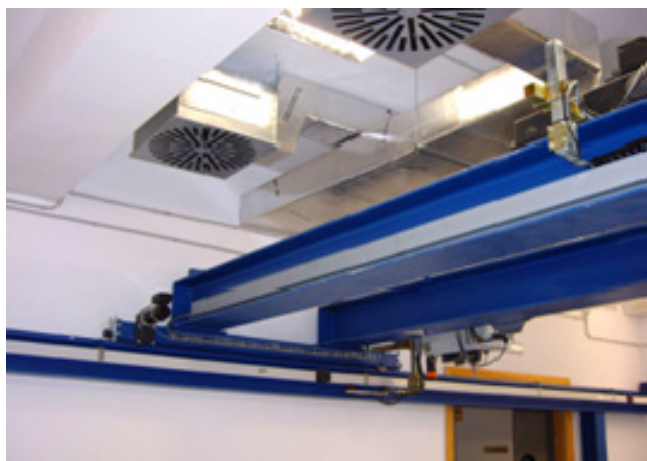
Fotografía 3: Instalación de puente grúa - Microsonda iónica - CIC
