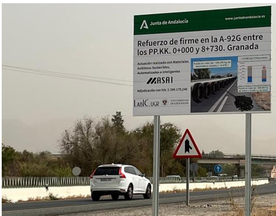
Figura 9. Detalle del cartel de obra de rehabilitación en A-92G con materiales MASAI.
