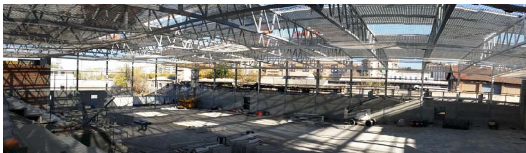
Interior de las obras del Pabellón de Fuentenueva.
