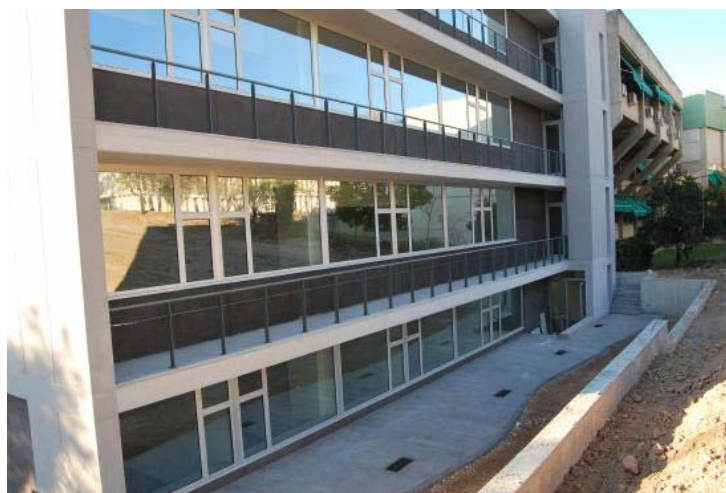
Fachada exterior de la ampliación de la Facultad de CC. Económicas y Empresariales
