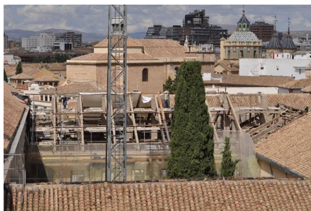
Montaje de toldos en cubierta
