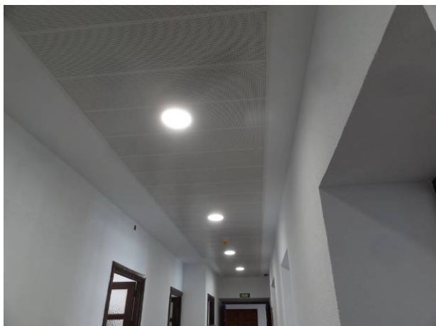
Acabado de falso techo en Dpto. de Penal
