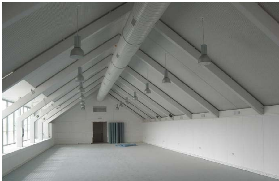
Interior del aula de proyectos arquitectónicos
