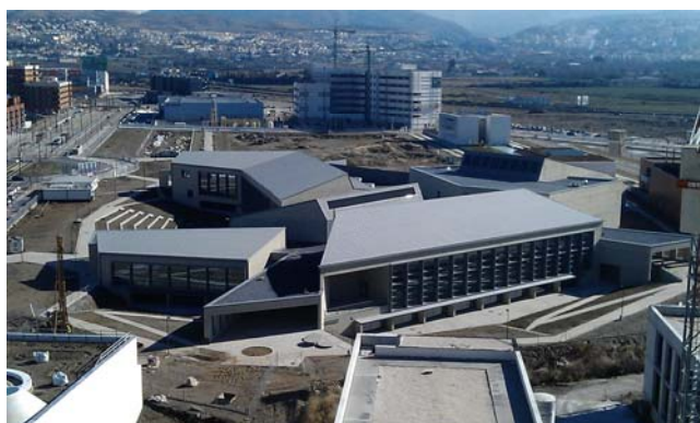
Vista general Edificio Servicios Generales
