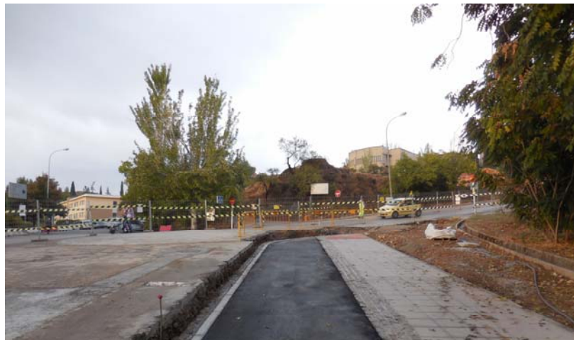
Obras de Reurbanización del Campus de Cartuja
