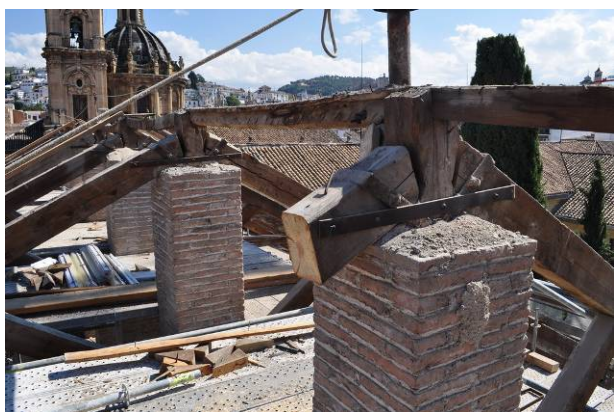
Desmontado de cerchas de la cubierta
