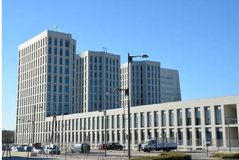
Imágenes del exterior de la Nueva Facultad de Medicina en el PTS
