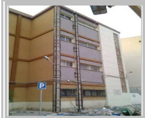
Reparación estructura edificio principal Campus Melilla.
