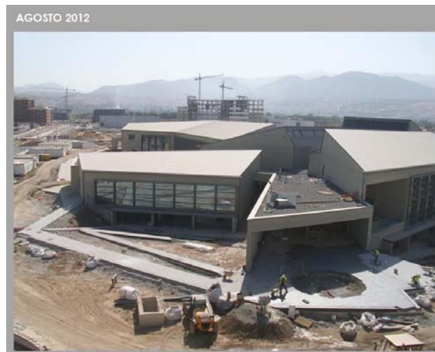
Estado actual del edificio de Servicios Generales.
