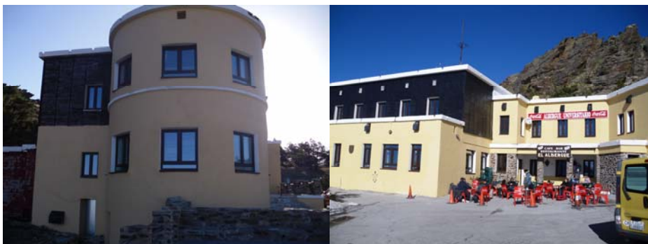
Mejora de la envolvente edificio. Sustitución ventanas Albergue Universitario
