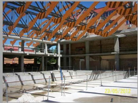
Situación de las obras de la nueva piscina de la FCCD
