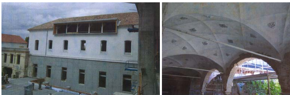
Situación de las obras del Hospital Militar como sede de la ETS de Arquitectura.
