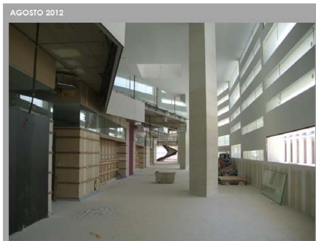
Estado actual del edificio de la Facultad de Ciencias de la Salud.
