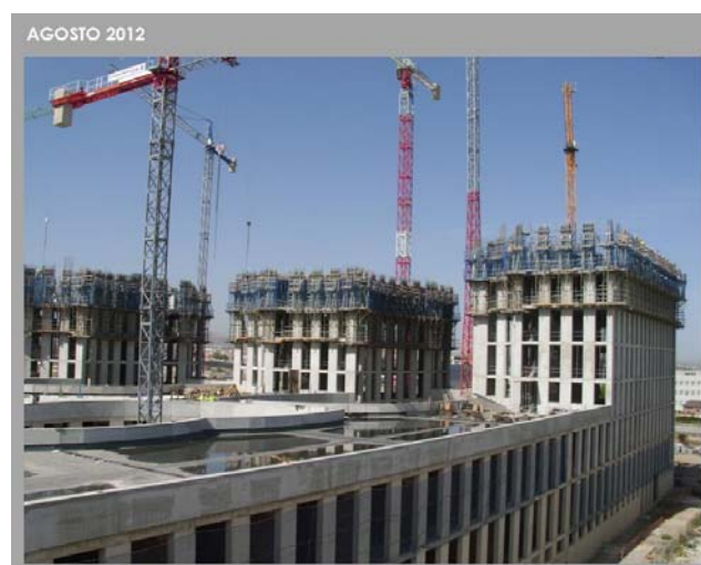
Estado actual de la Facultad de Medicina.
