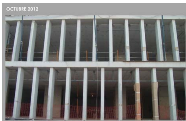
Estructuras Nuevo Módulo de la Facultad de CC Económicas y Empresariales
