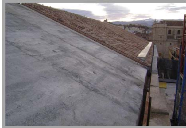
Rehabilitación de cubiertas en la Facultad de Políticas y Sociología.
