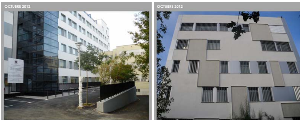
Sección de Biológicas. Facultad de Ciencias. Finalización de las Obras
