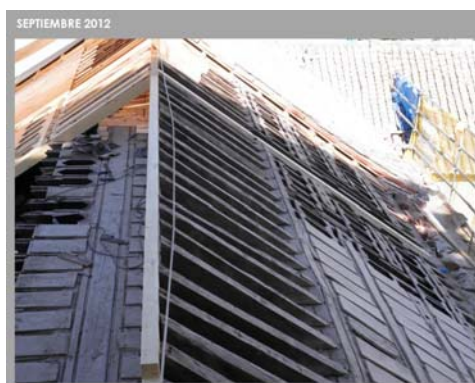
Restauración de las cubiertas del Patio de los Inocentes
