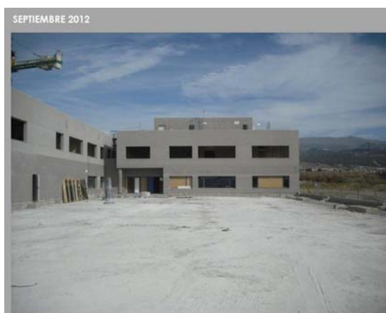
IMUDS. Situación de obra
