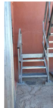
Nuevo acceso a la cubierta para mantenimiento
