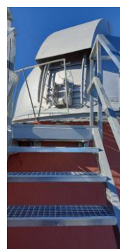
Nuevo acceso a la cubierta para mantenimiento
