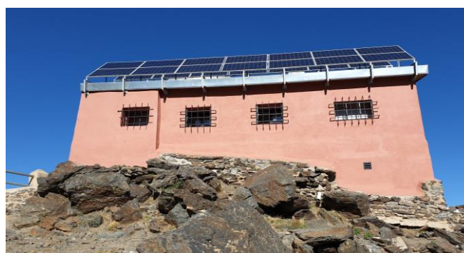
Instalación de placas fotovoltaicas en la cubierta para generación de energía eléctrica de forma sostenible y autónoma.
