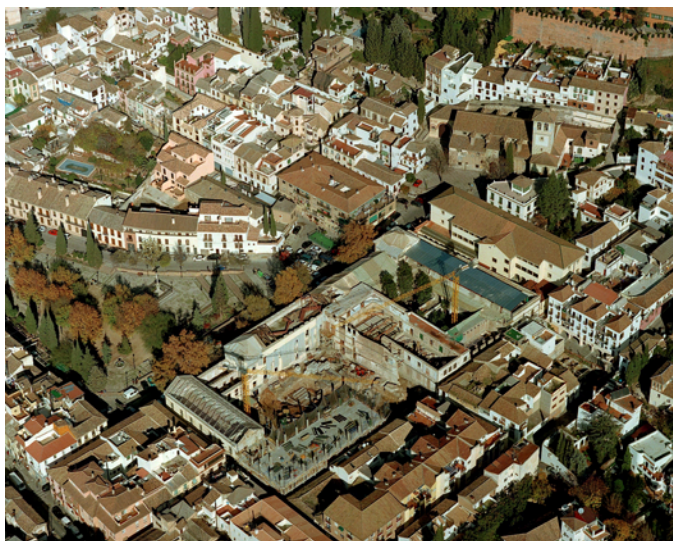
Fotografía 5: Vista aérea del Hospital Militar (ETS de Arquitectura)
