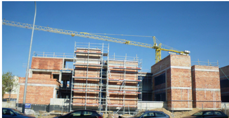
Fotografía 4: Obras de construcción del CITIC
