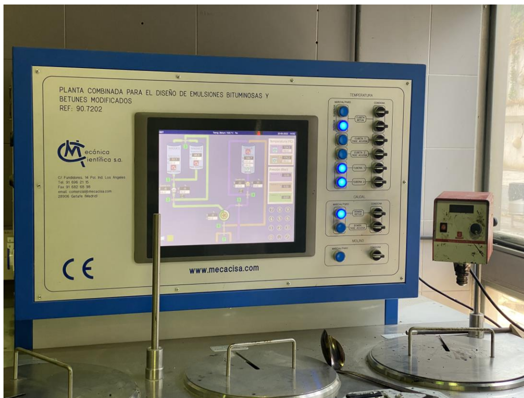
Figura 5. Detalle de la planta de fabricación de betunes modificados y emulsiones bituminosas.
